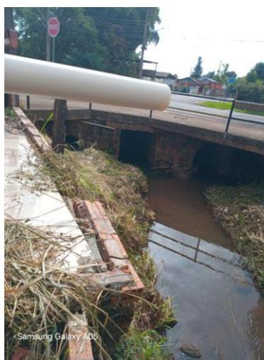
Moradores da região relatam que o acúmulo excessivo de galhos e resíduos em determinados pontos tem causado obstruções na drenagem, especialmente em dias de chuva. Essa situação resulta no rápido acúmulo e transbordamento de água, afetando a via pública e invadindo residências próximas. A
